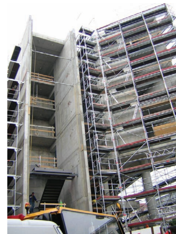
Treppenhaus mit Schacht für Glasaufzug
