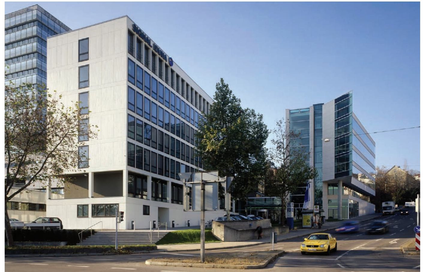
Blick Heilbronner Strasse
